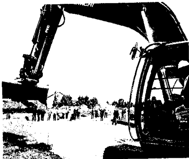
An der Rankestraße rollt der erste Bagger: In Allerheiligen B wird das Neubaugebiet erschlossen.
